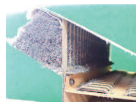
電気炉による加熱試験
